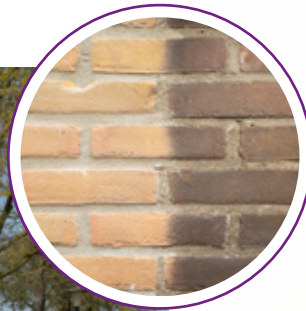
De gevels worden ook grondig gereinigd. Hier zien we het verschil.
