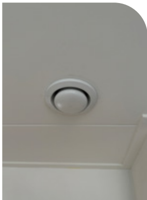
Foto van een lucht afzuigventiel
