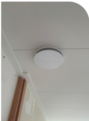
Foto van een lucht inblaasventiel
