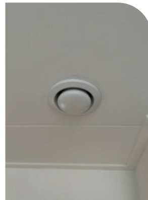
Foto van een lucht afzuigventiel
