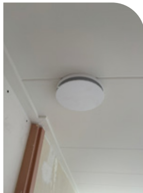
Foto van een lucht inblaasventiel
